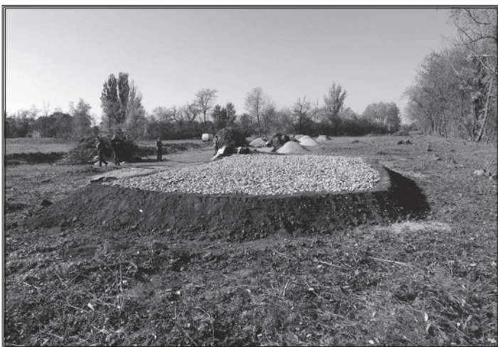
Будівельні роботи у Вахнівці (Нове єврейське кладовище)
